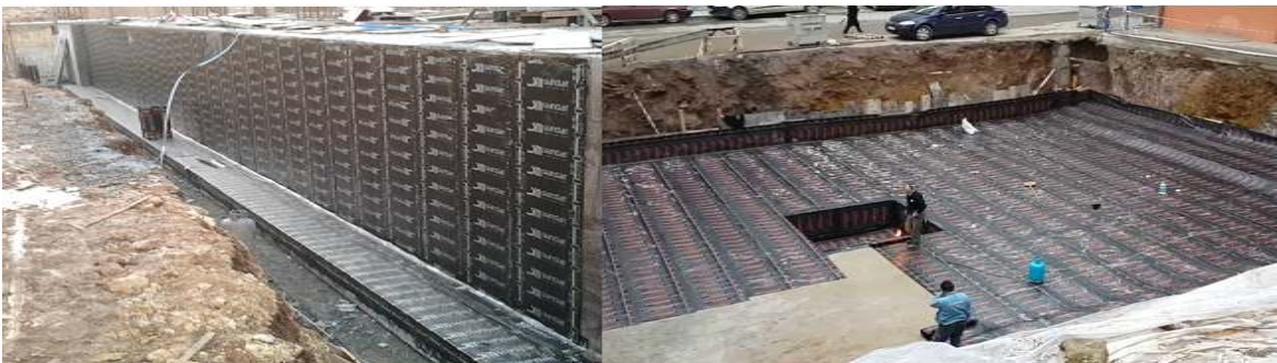
Şekil 4. Bina Temelinde Bohçalama Yöntemi ile Su Yalıtımı Yapılması
